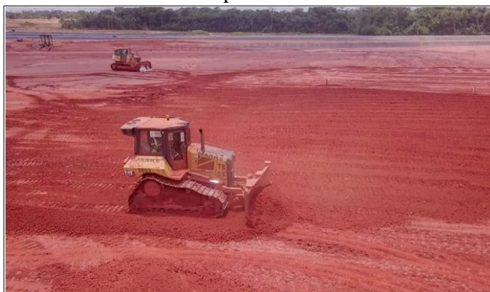
Figura 2.14 - Resíduos de empilhamento seco dos filtros de prensa.
